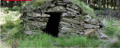
Afin de se protéger des intempéries, les bergers se construisaient des abris sommaires en pierres sèches : des jasses. Vous pourrez les découvrir au détour du sentier « le puech dels carboniès ».
